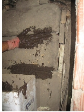
Şekil 22 Yükleme Kapısının Sıvanması
