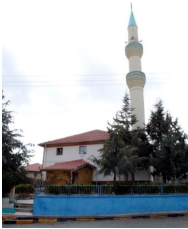
Fotograf 1: İbrahim Çavuş Camii Kuzey Cepheden Görünüş
