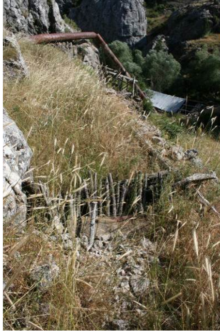
Fotoğraf-12: Mazgal, su boruları ve değirmenin genel görünüşü
