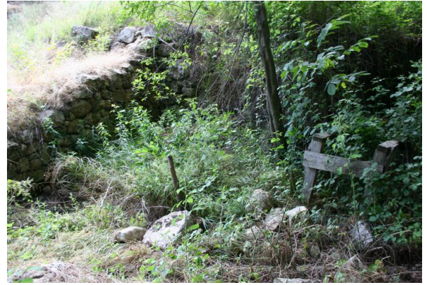
Fotoğraf-21: Kayrak Değirmeni güney kanadı
