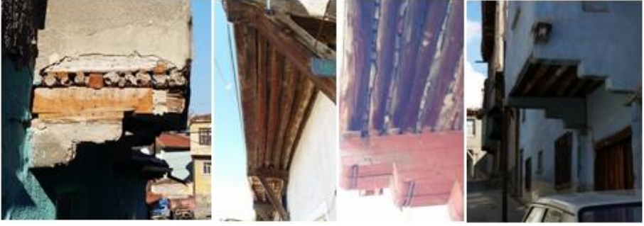
Fotoğraf 17. Çıkma Altı ve Döşeme Detayları (Dikmen ve Toruk Arşivi)
