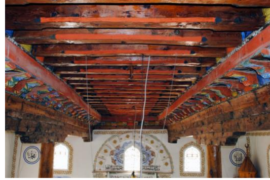
Fotoğraf 10: İbrahim Çavuş Camii, Ahşap Hatıllı Tavan
