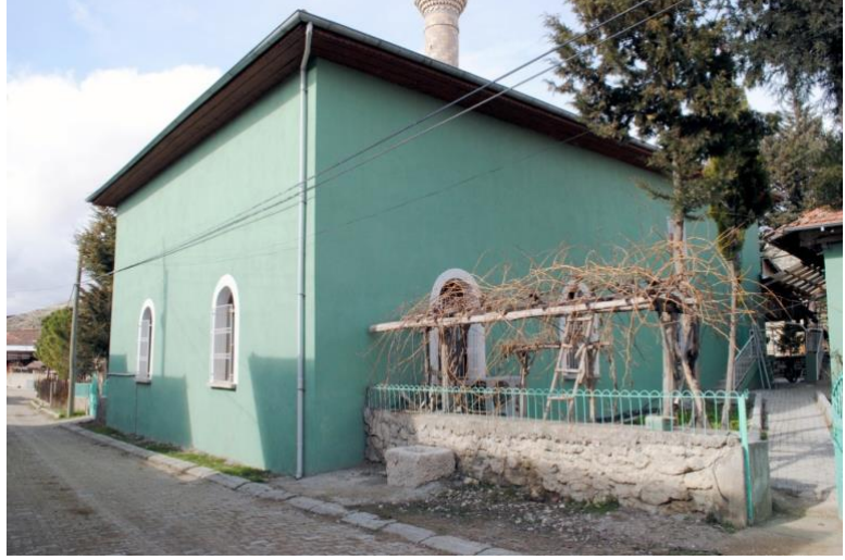
Fotoğraf 28: Elmacık Köyü Camii Batı ve Güney Cepheden Görünüş
