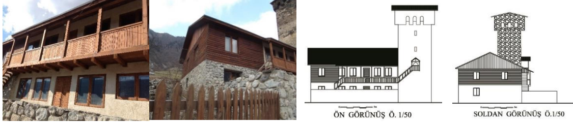
Resim 8. 3 numaralı Svan evine ait dış mekân ve cephe görünüşleri
