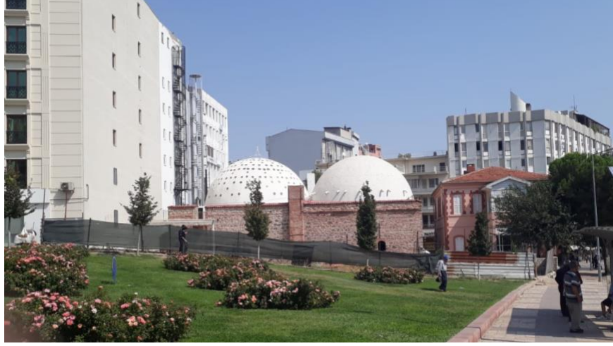
Görsel 3. Hamam Yapısının Arka Cephesi, Kişisel Arşiv, 2022, Denizli.
